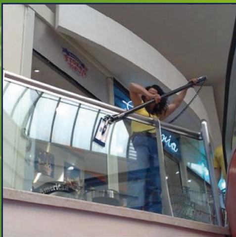
Questa nuova tecnica consiste in un sistema di **aste telescopiche** in **carbonio** che si uniscono tramite delle clips in acciaio permettendo così di arrivare fino a 12 mt di altezza senza l'utilizzo di piattaforme aeree e con l'operatore in **estrema sicurezza**.
